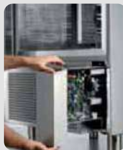
Cuadro eléctrico extraíble facilita la manutención
